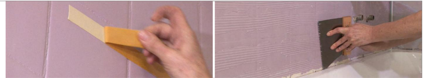
Montage test à blanc avec ruban adhésif double face. Encollage de la totalité du mur au silicone **neutre transparent** avec une spatule crantée.
