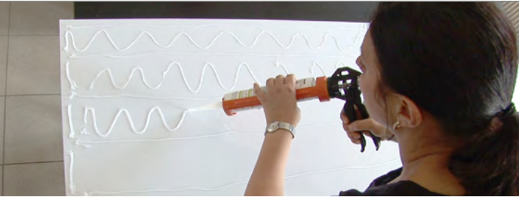
Montage test à blanc avec ruban adhésif double face. Encolage avec du silicone neutre transparent .
