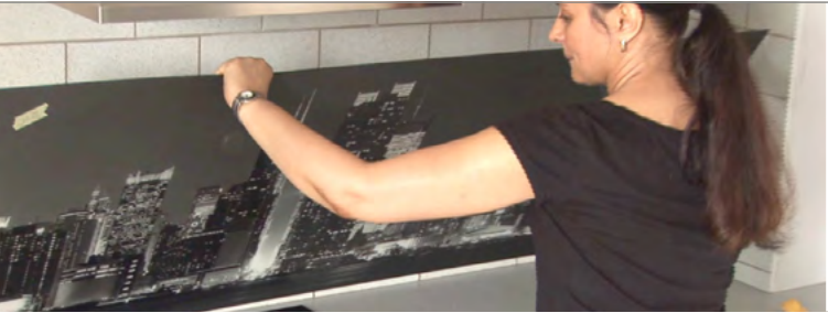
Montage test à blanc avec ruban adhésif double face. Encolage avec du silicone neutre transparent .
