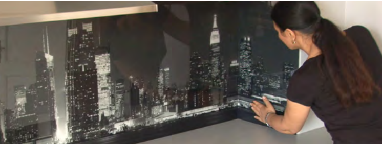
Pose de la crédence 1 en raccord parfait avec la crédence 2.
